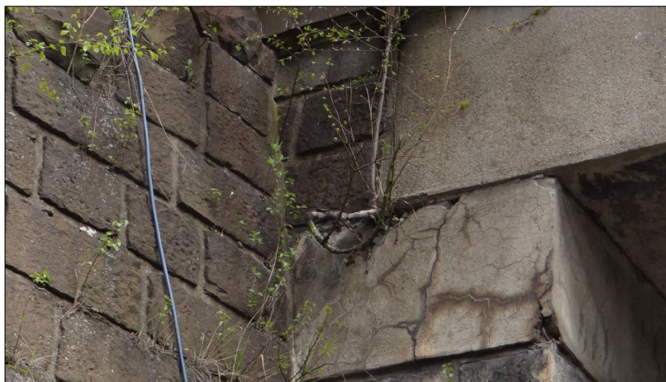
Obr. 30 Vegetace na úložním prahu a křídle opěry – OP2
