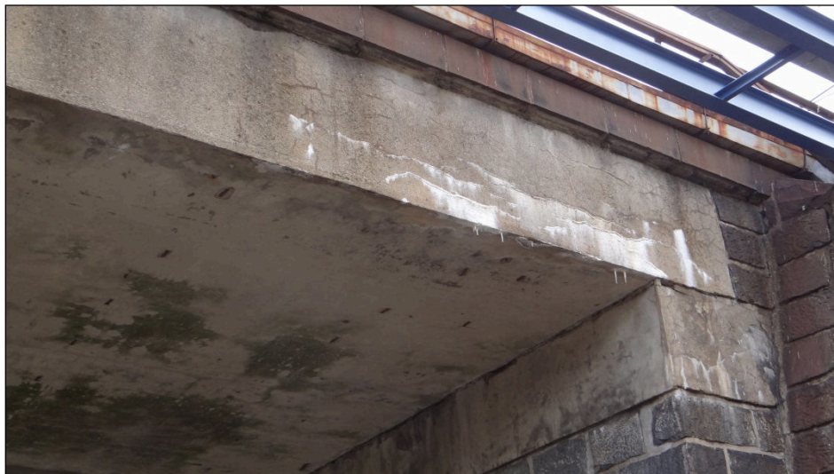
Obr. 29 Trhliny v betonu nosné konstrukce i úložného prahu
