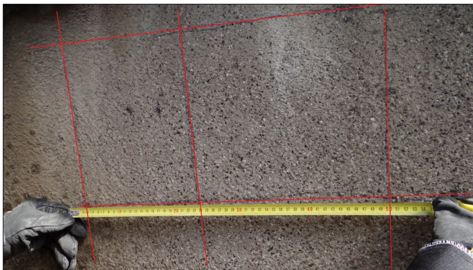
Obr. 19 Rozdělení výztuže na boku nosné konstrukce
