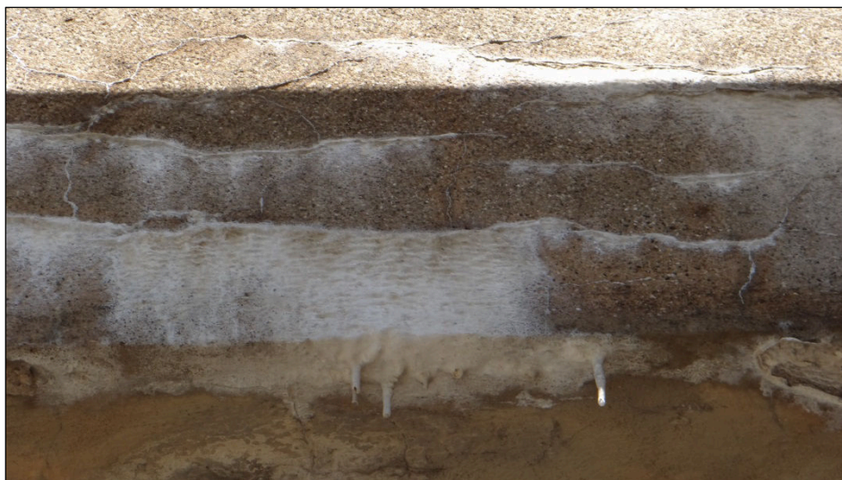
Obr. 23 Výluhy s výluhovými krápníky - detail
