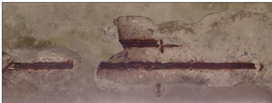
Obr. 24 Odpadlá krycí betonová vrstva a zkorodovaná nosná výztuž
