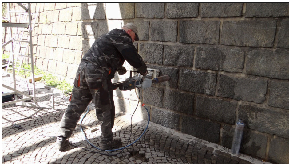
Obr. 9 Vrtání diamantovou korunkou s vodním výplachem – vrt V0
