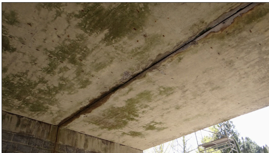
Obr. 20 Protečení podélné dilatační spáry
