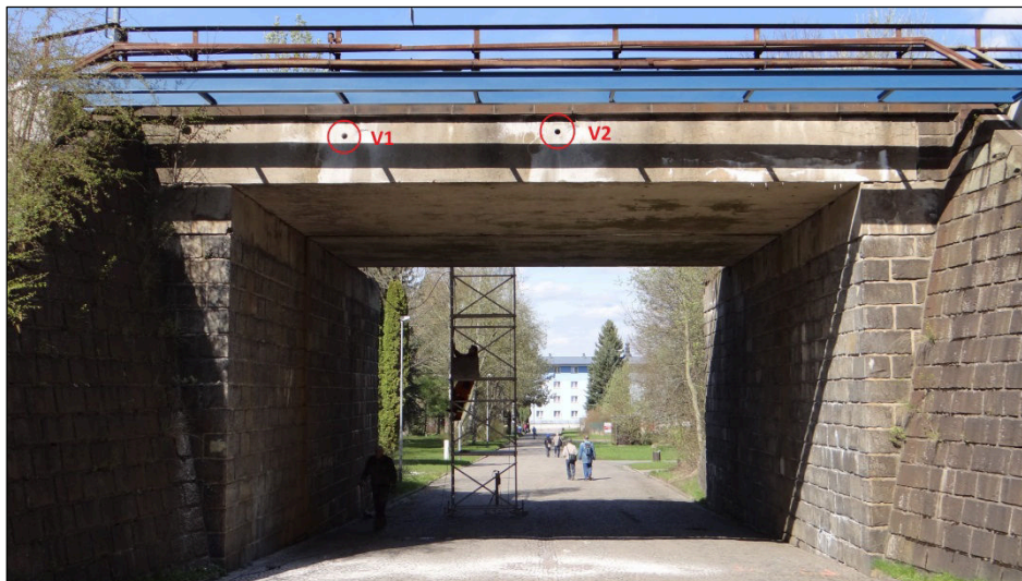
Obr. 11 Pohled na místa odběrů vrtů V1 a V2
