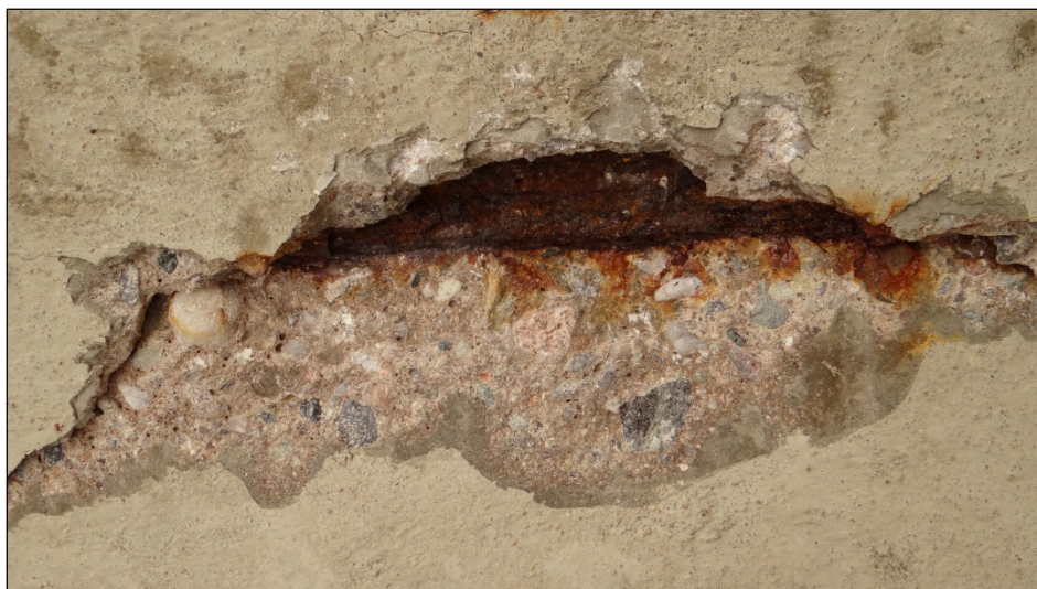
Obr. 27 Nedostatečná tloušťka krycí vrstvy betonu
