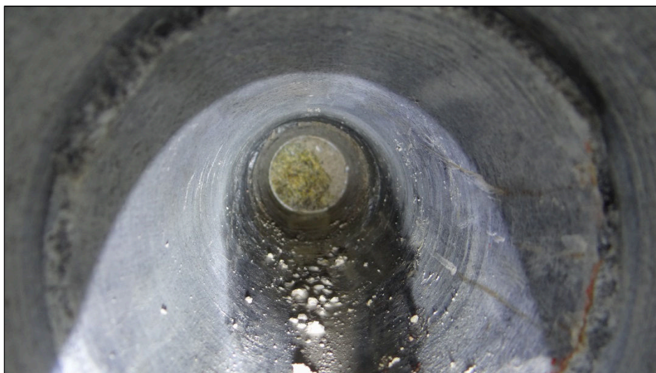
Obr. 9 Vrtání diamantovou korunkou s vodním výplachem – vrt V0
