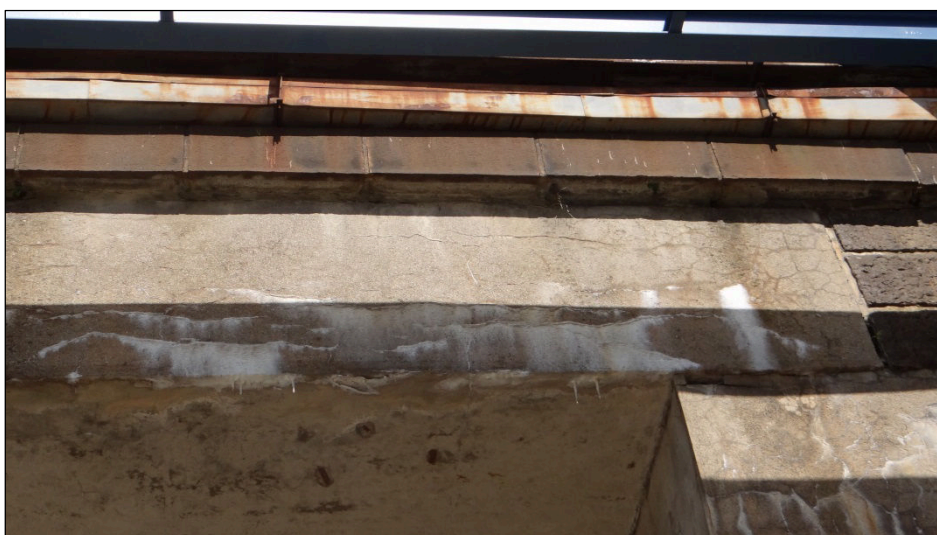
Obr. 22 Bok mostu pokryt výluhy s výluhovými krápníky
