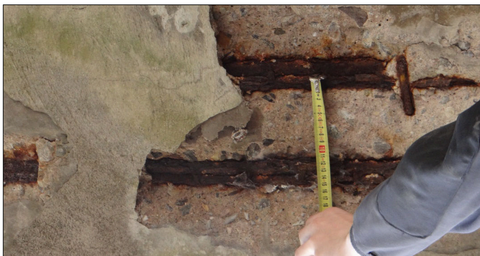
Obr. 17 Odhalená nosná výztuž
