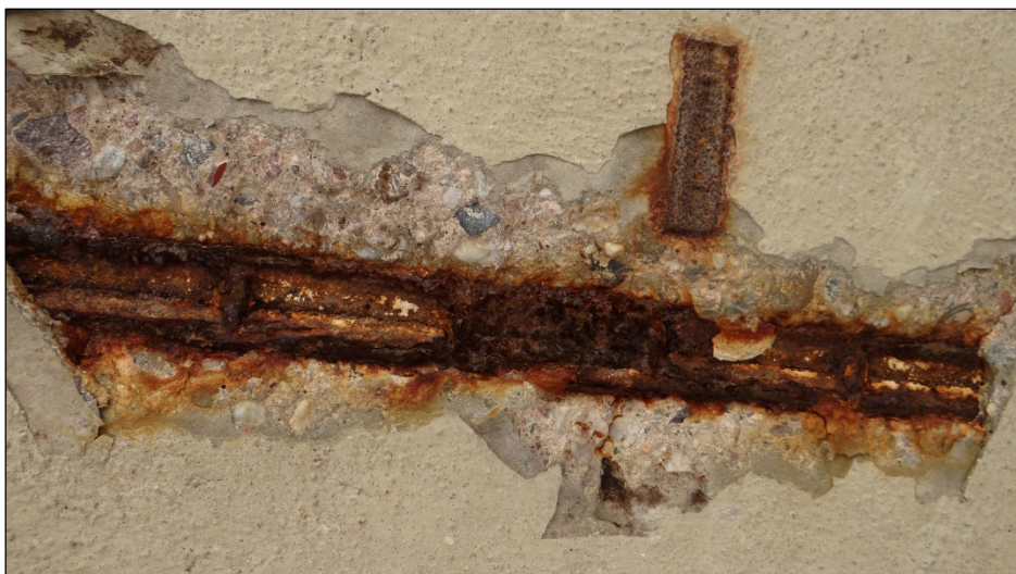
Obr. 25 Detail zkorodované výztuže
