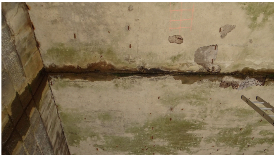
Obr. 21 Voda z dilatační spáry stéká po opěře
